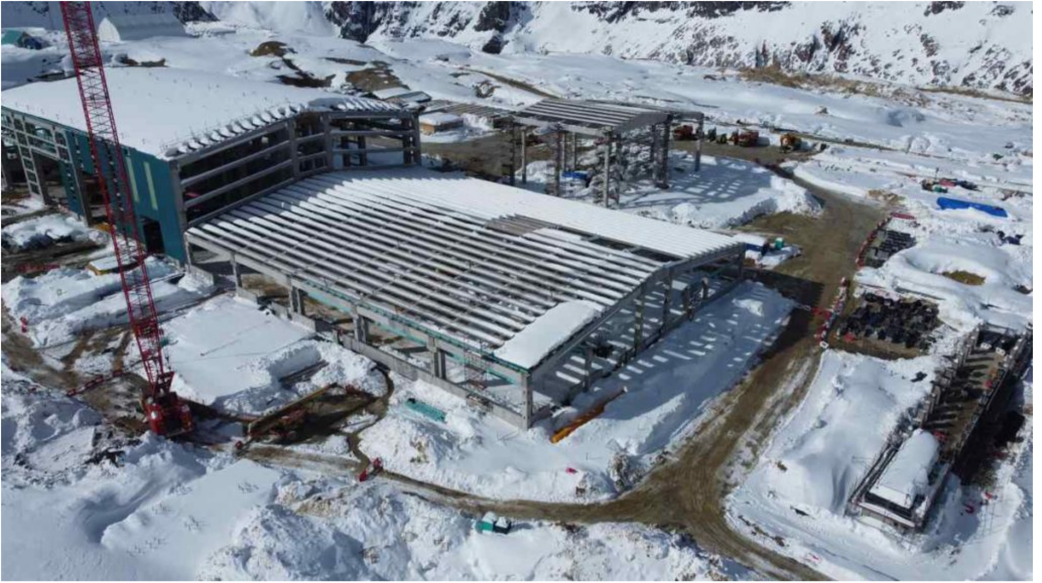
Foto: Una de las particularidades del diseño sísmico es que consideró la sobrecarga por nieve. Crédito: Gentileza Salfa Montajes
