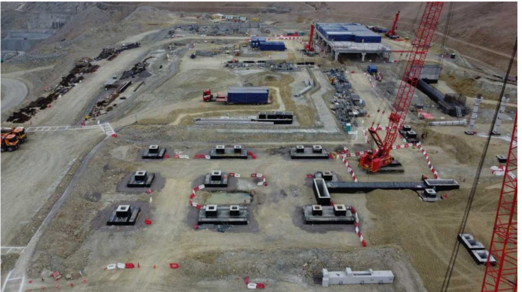
Foto: Fundaciones del Truck Shop. Crédito: Gentileza Salfa Montajes
